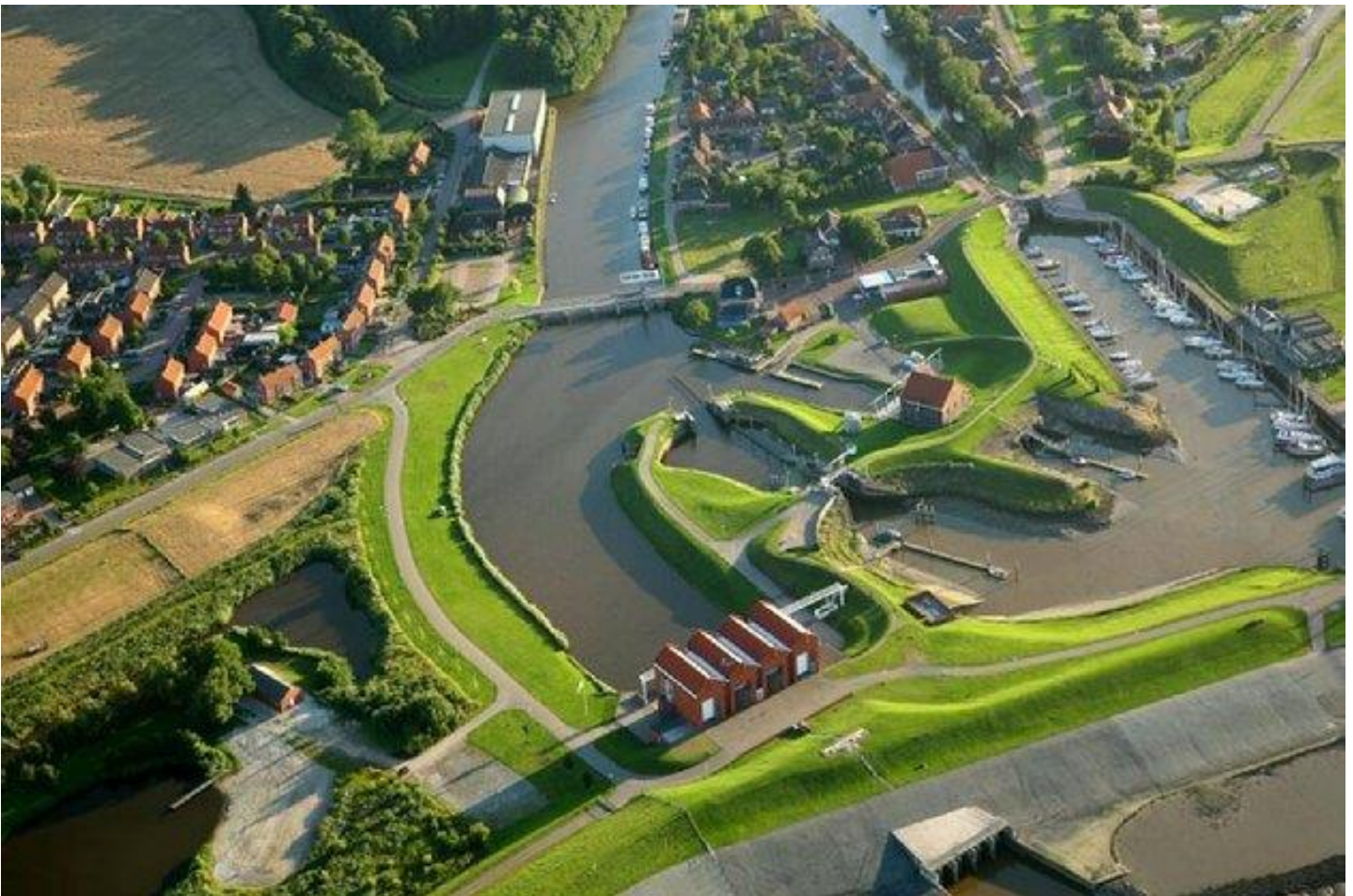
Links het Gemaal Rozema, rechts het oude Gemaal Cremer.
